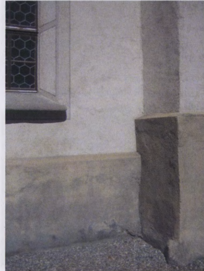
Sockel / Verputzschäden
