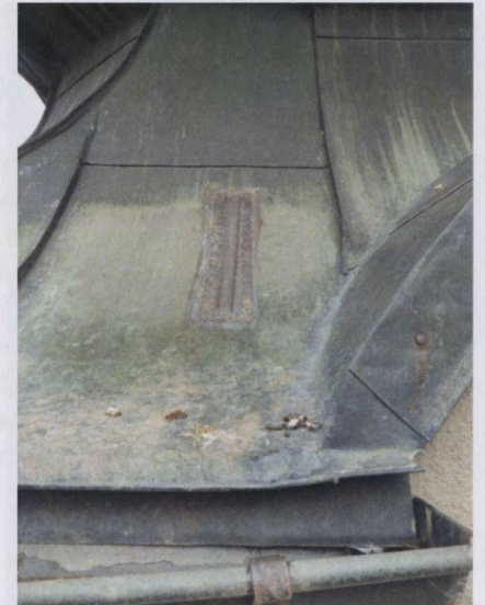
Flickstelle Dach Turm
