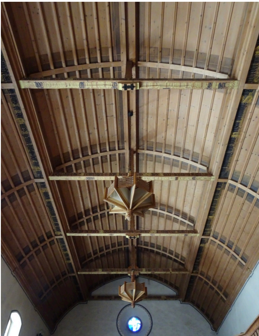
Geschweifte Holzdecke mit Zugbalken; hölzerne Deckenleuchten in reformerischem Design
