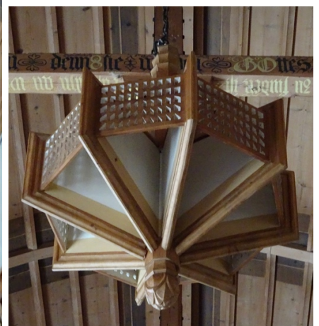
Geschweifte Holzdecke mit Zugbalken; hölzerne Deckenleuchten in reformerischem Design
