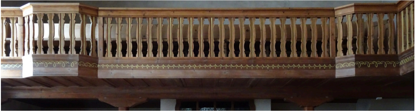
Emporengeländer: gesägte Flachbaluster mit eingelegten, grünlichen Profilstäben
