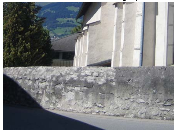
Friedhofsmauer / Frostschäden
