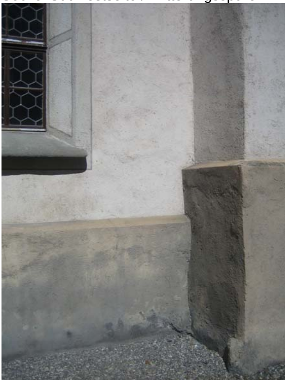
Sockel / Verputzschäden
