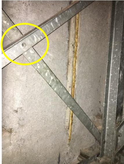
Andreaskreuz mit fehlender Schraube (b. Aufgang)
