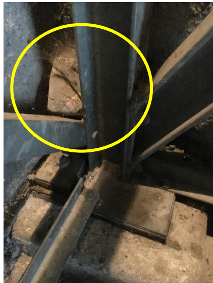
Eckpfosten in der NW Ecke mit verklemmtem Stein
