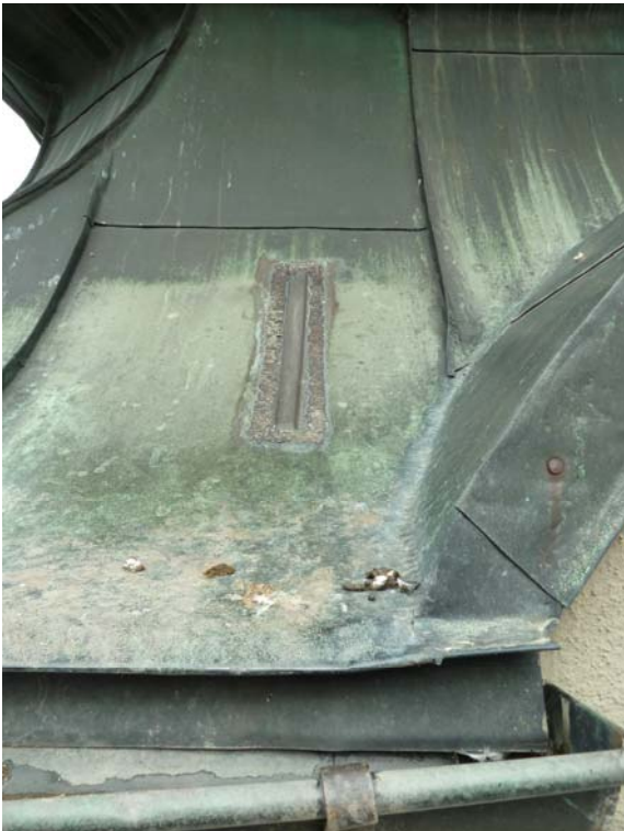
Flickstelle Dach Turm
