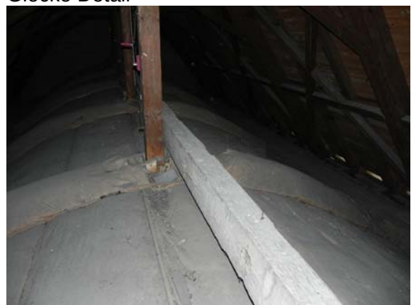
Dachstuhl / Dämmung Holzdecke Schiff
