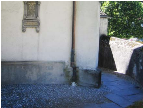
Sockel / Feuchteschäden
