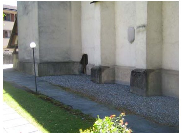
Sockel Nordostseite / Witterungsspuren
